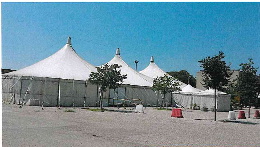
Alcune foto della tensostruttura
