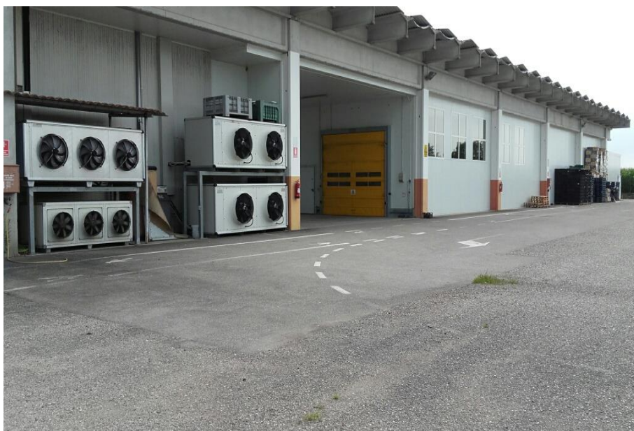
Piazzale esterno - entrata
